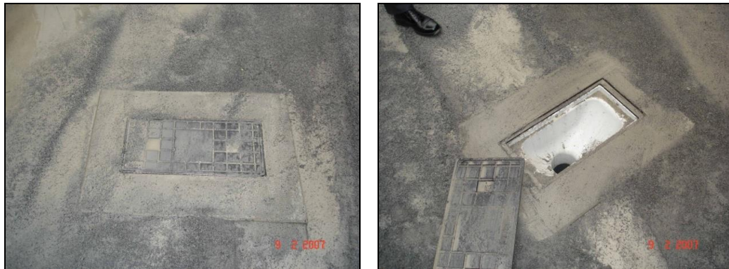
شکل ۵: نمونه‌ای از سرویس‌های بهداشتی قابل استفاده برای شرایط اضطراری
